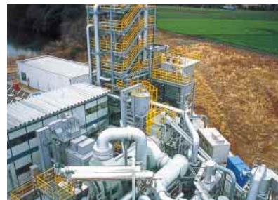
キルン式ガス化システムの実証プラント (処理規模: 20t/日 〓 びたちなか市)
