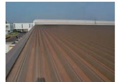
日立グローバルストレージテクノロジーズ(タイ)社の断熱塗料を塗布した屋根。
