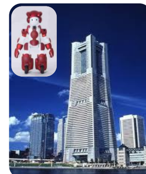
日本 横浜ランドマークタワー (EMIEW3, EMIEW-TT) 〈三菱地所〉
