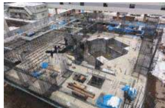
北海道大学：建物建設状況
