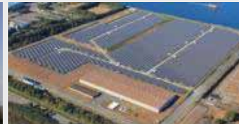
太陽光発電 システム
